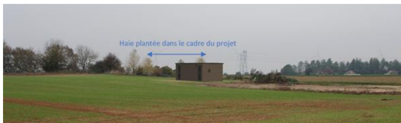
Figure 18 : photomontage du poste de livraison avec bardage bois et haie le long du chemin agricole depuis la route Cressy/Biarre
